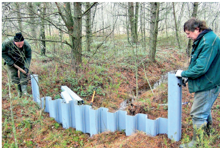
6 a, b pav. Plastikinių ir durpinių užtūrų įrengimas, 2021 m. gruodis. Ž. Sinkevičiaus nuotr.
