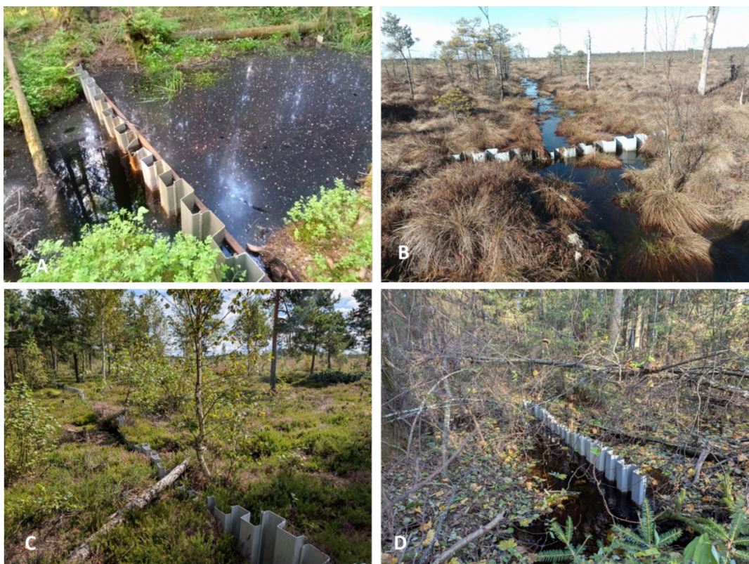
41 pav. Funkcionuojančių (A, B) ir deformuotų ar netinkamai įrengtų pertvarų iš plastikinių spraustasielių pavyzdžiai Aukštajojo Tyro pelkėje
