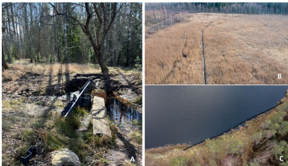
33 pav. Plastikinių sprasutasienių užtvaros stabdančios vandens nuotėkį iš sausinimo griovių bei Kulio ir Ešerinio ežerų (B, C).
