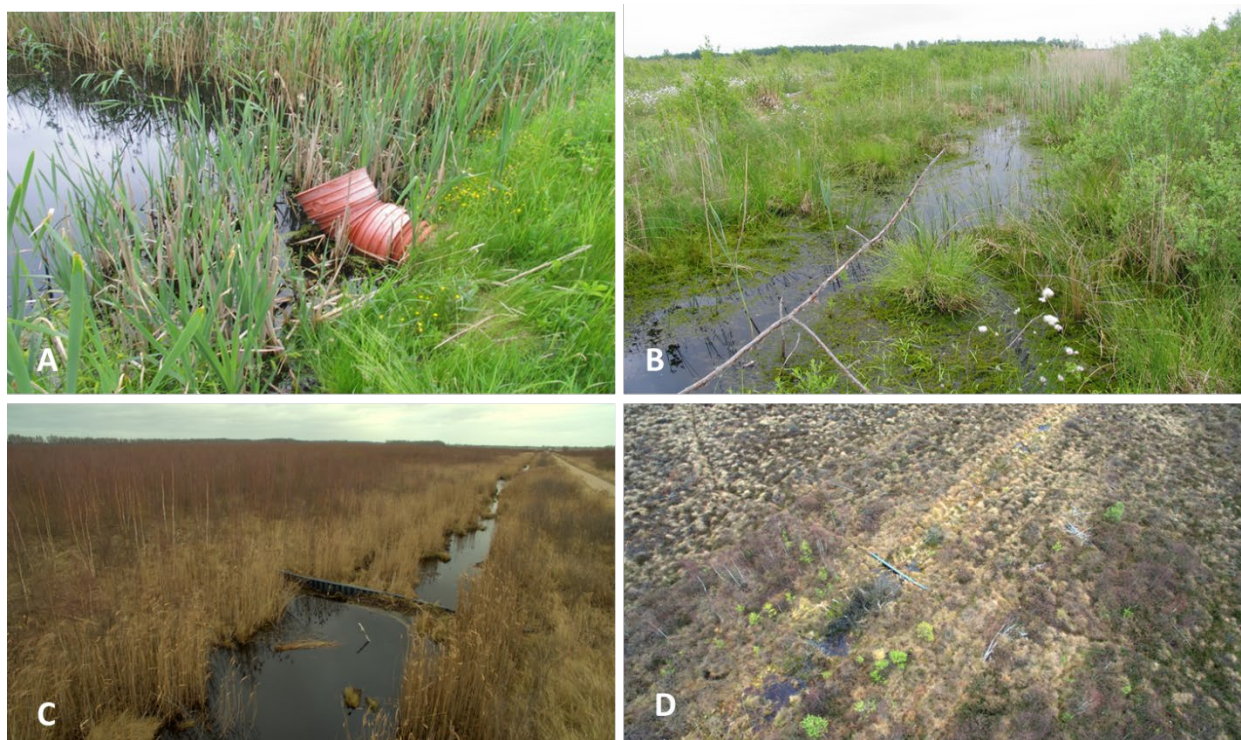
56 pav. Amalvos pelkėje įrengtos pertvaros iš plastikinių spraustasienių (B-D) bei kompleksinė užtvanka su vandens pertekliaus nutekėjimo vamzdžiu
