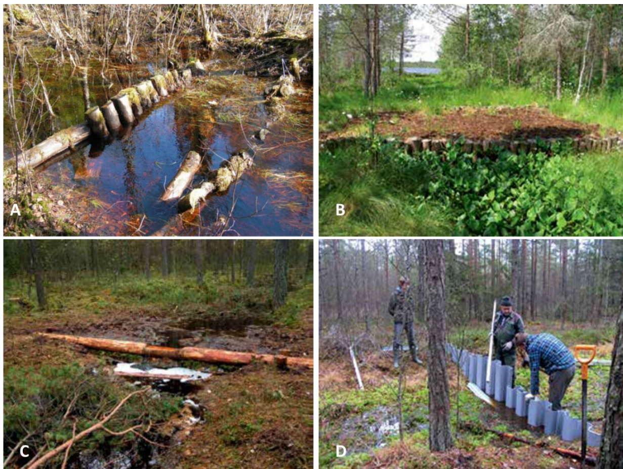
55 pav. Užtvankų tipai Paislio kanale: polinė–durpinė (A – išplauta, B – sulaikanti vandenį), rąstinė su geomembrana (C), polichlorvinilinių spraustlenčių (D) užtvanka.
