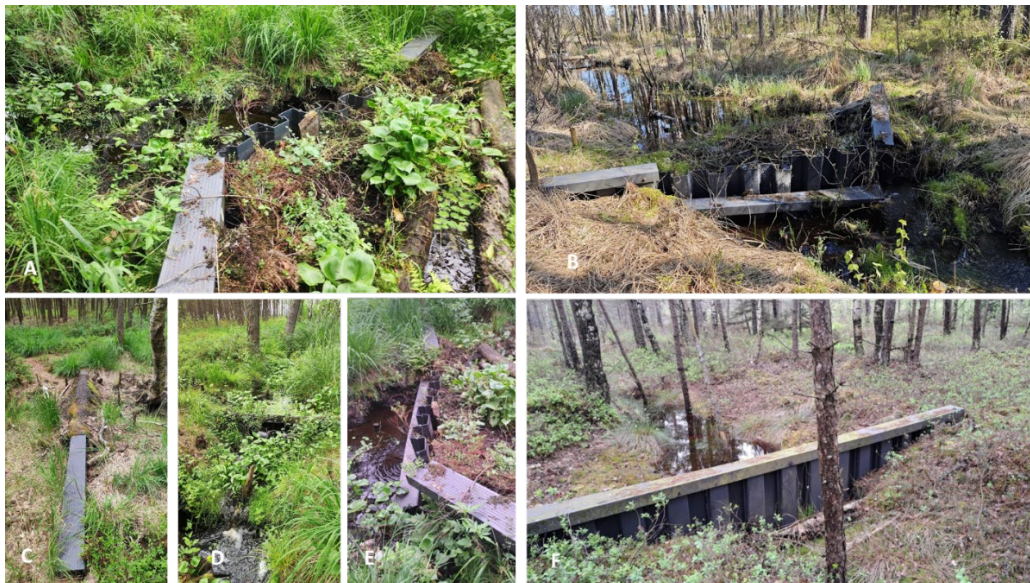
45 pav. Deformuotų užtvankų iš plastikinių spraustasielių pavyzdžiai ant ištiesinto Duburo upelio (A–E) bei vandens nuotėkį sulaikančios užtvankos pietrytinėje pelkės dalyje pavyzdys (F).
