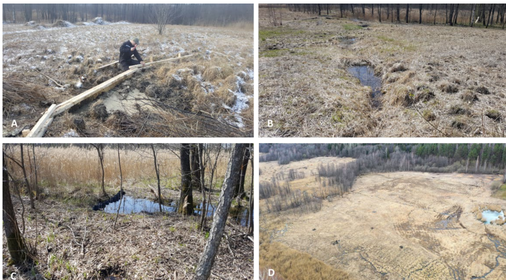
39 pav. Tartoko pelkės hidrologinio režimo atkūrimas. Griovių blokavimas medinėmis MDF plokštėmis (A, B) ir plastikinėmis spraustasienėmis (C), vaizdas iš viršaus po visų gamtotvarkos darbų įgyvendinimo (D).
