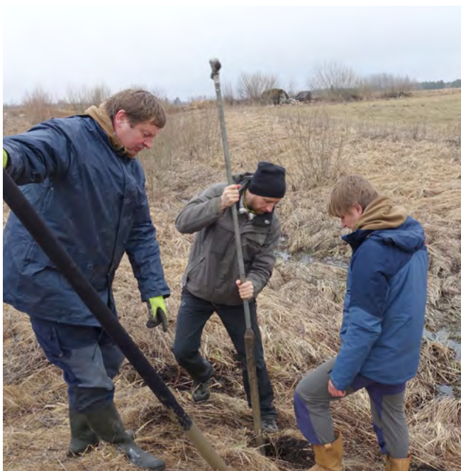
Įrengtos hidrologinio monitoringo ir aplinkos pokyčių vaizdo fiksavimo sistemos.
