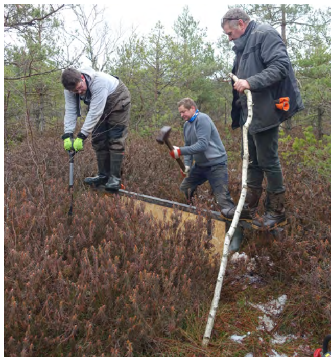
Įrengta apie 250 įvairių konstrukcijų užtūrų, skirtų vandeniui sulaikyti draustinio teritorijoje, hidrologinis režimas pagerintas 50 ha plote, įrengta hidrologinio monitoringo sistema.
