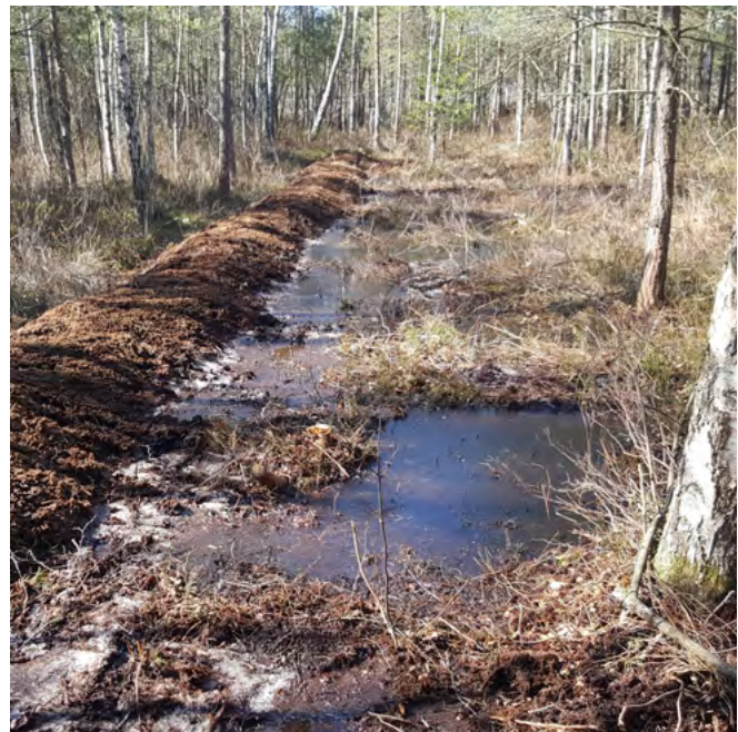
Pietvakarinėje Aukštumalos aukštapelkės dalyje (kairėje) įrengtas vandenį sulaikantis pylimas (dešinėje)
