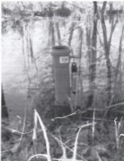
Įrengta hidrologinio monitoringo sistema.
