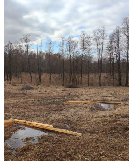
Ant pelkė sausinančių griovių įrengtos įvairių konstrukcijų vandenį sulaikančios užtūros.
