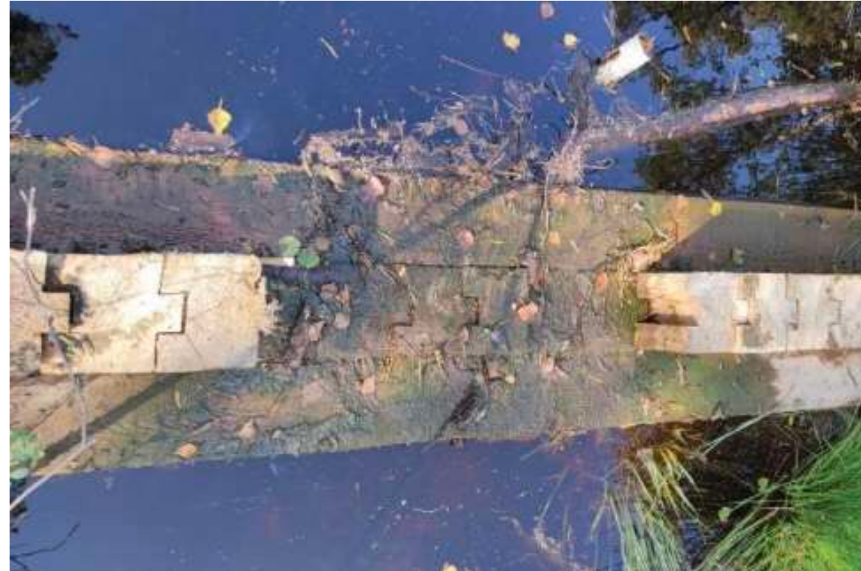
3 pav. Medinių spraustasienių (plotis 20 cm) pertvara su perteklinio vandens nutekėjimo anga, Svencelės aukštapelkė, Lietuva.
