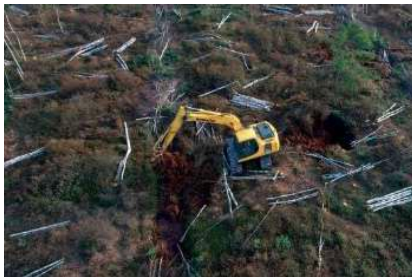
1 pav. Įrengta durpinė užtvara Lenkijoje (kairėje) bei durpinės užtūros įrengimas naudojant techniką Lietuvoje (dešinėje).
